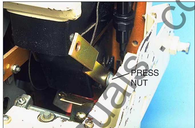
Fig. 32 Installing the Press Nut
