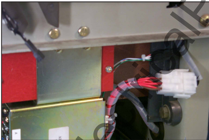
Fig. 42 Aux. CT Harness Connected to the Aux. CT Module Pigtail.
